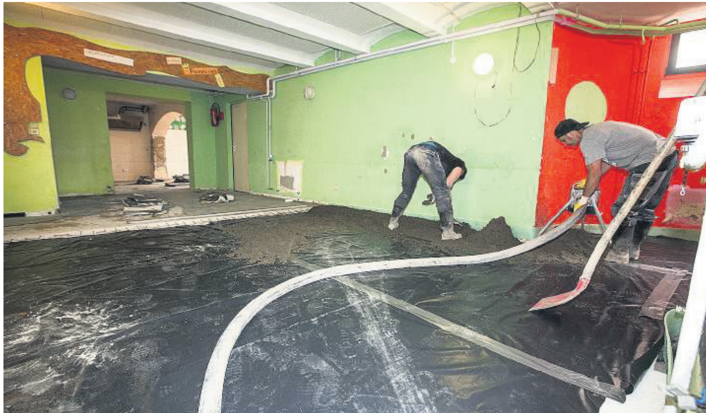
Im Jugendtreff im Keller der Alten Polizei wird neuer Estrich gelegt.
