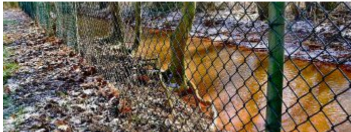
Am Spielplatz im Wolfskamp soll entlang der Gehle ein Erdwall zum Hochwasserschutz gebaut werden.
